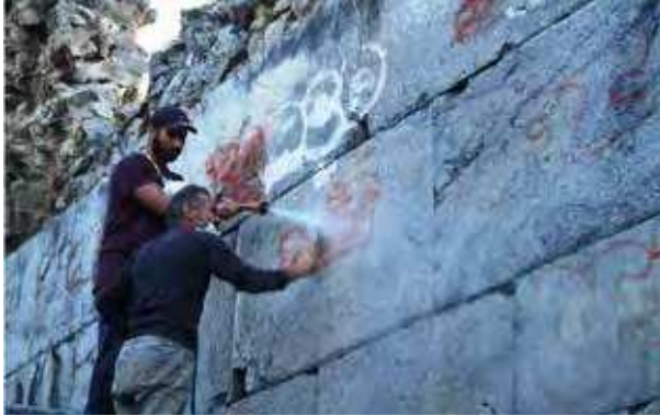
Resim 9: Taş ve duvar temizliği çalışması
